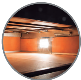
Cámara, ladrillos refractarios
